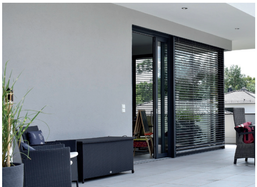
ABB. 5: Zugang zum Freisitz mit 20-mm-Schwelle
